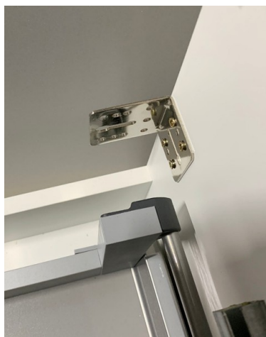
Fig. 5a | Équerre de montage Visser
