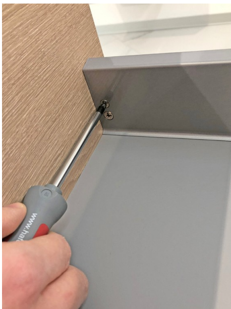
Fig. 3 | Réglage en hauteur des tiroirs
