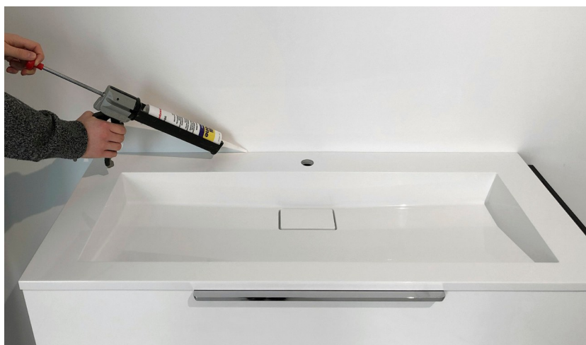
Fig. 6 | Montage du lavabo / Étanchéification au mur avec du silicone
