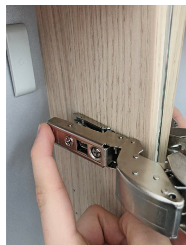
Fig. 1c | Montage de la porte miroir
