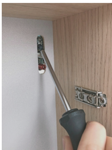
Fig. 2b | Réglage des supports d'armoire
